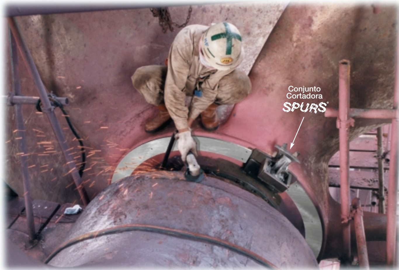
Cortadora Spurs para barcos grandes montada sobre el Moyú de la Hélice
